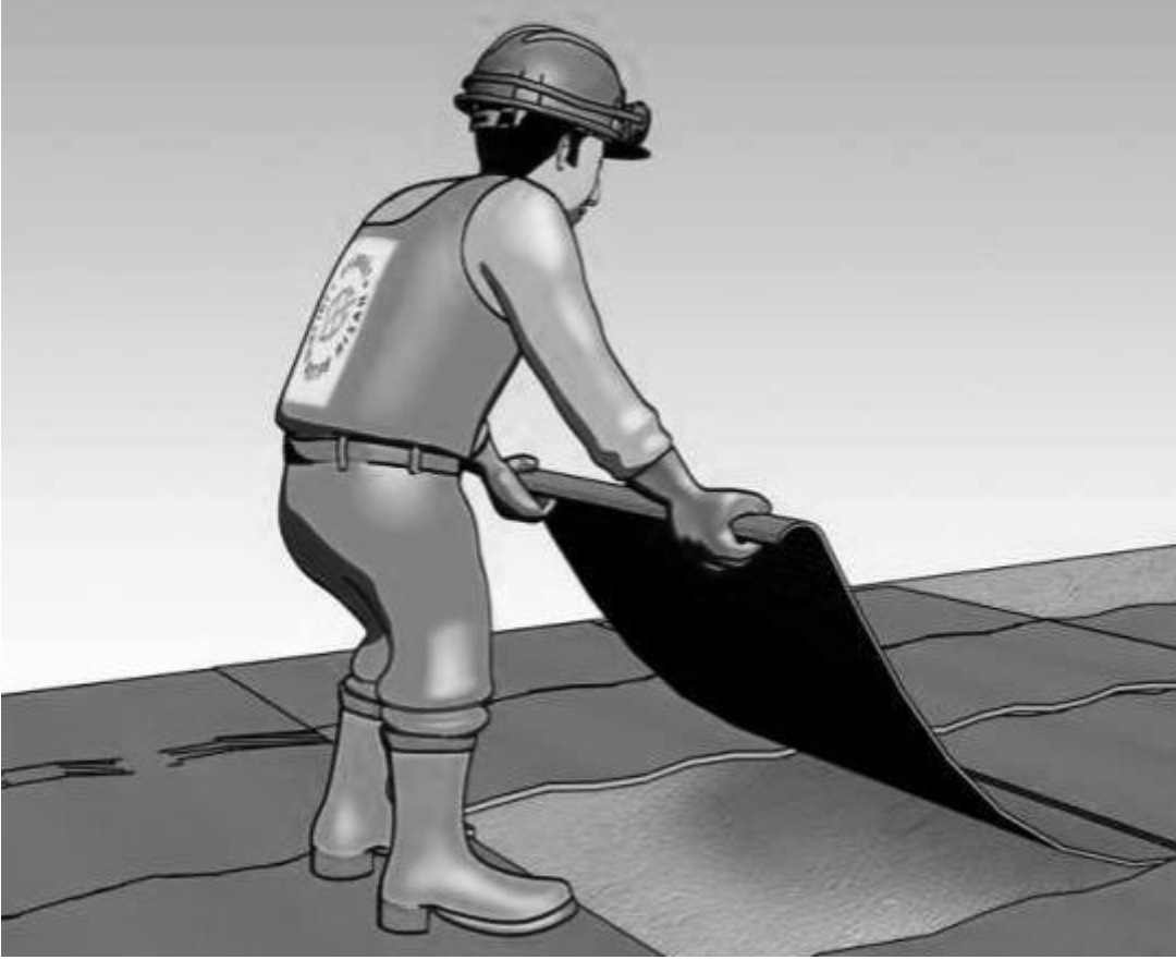
Resim 12: Beton yüzeyine telis bezi serilmesi Kimyasal Maddeler ile Kür Yapılması
