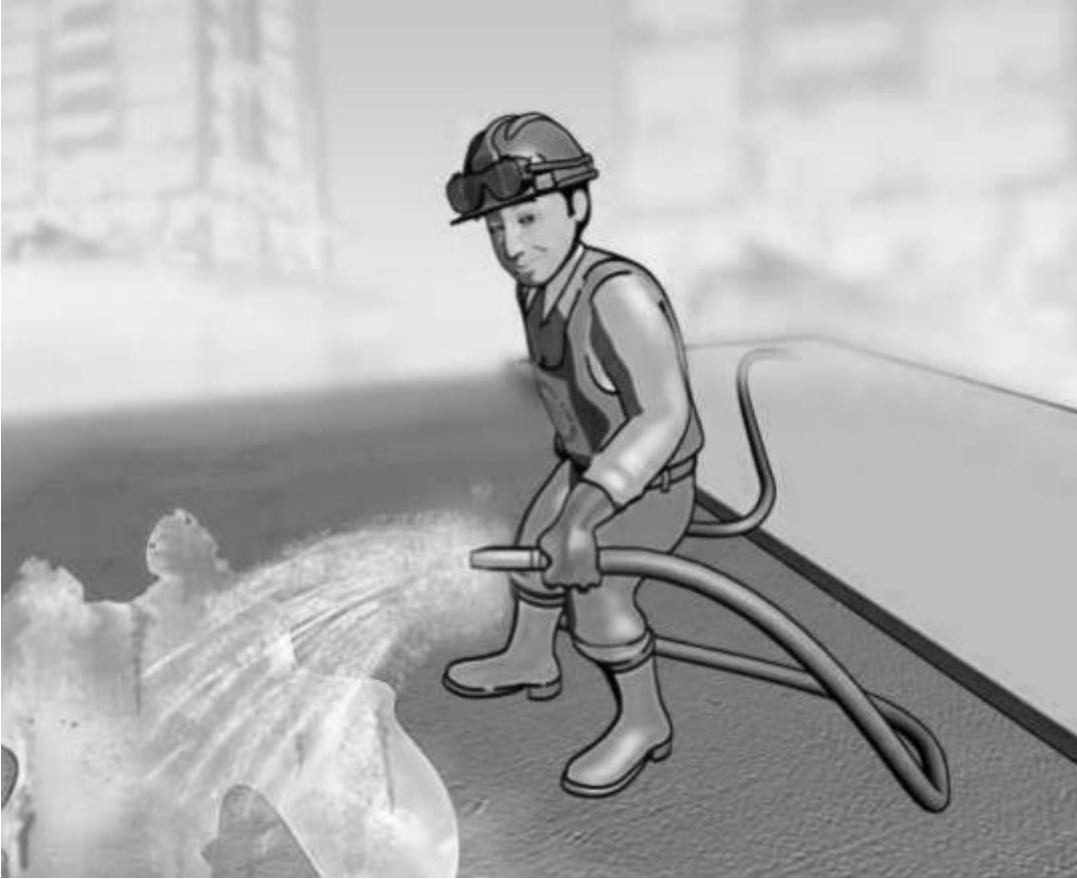
Resim 10: Beton yzeyinin hortumla sulanması
